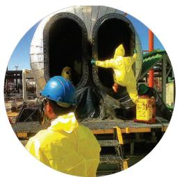
LAPS cuenta con la experiencia para realizar mantenimientos y limpieza a equipos para tratamiento de crudo, para ello contamos con equipos y herramientas de última generación, para hacer los procesos más eficientes, seguros y rápidos.
